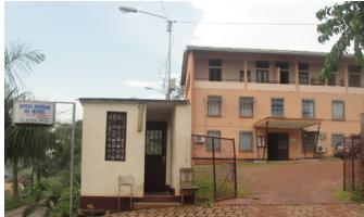
Entrée principale de la CDO
